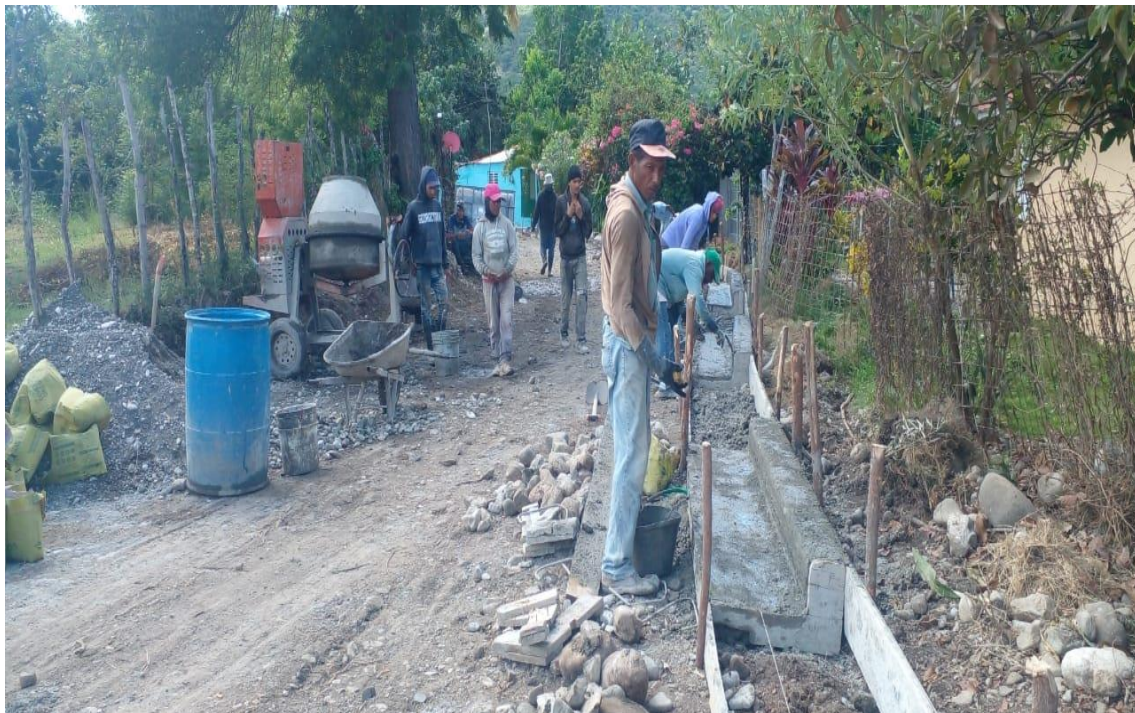
Continuación de aceras y contenes, sector de Bayona.
